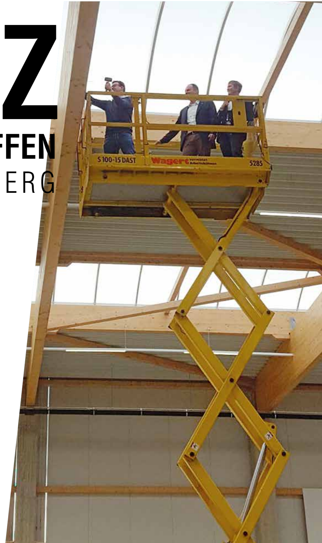
Philipp Zumsteg und Rainer Dressler setzen den letzten Nagel beim Richtfest.
